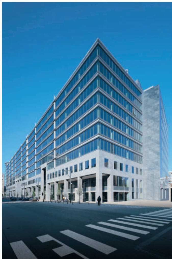
Die hausInvest europa -Büroimmobilie „City Atrium“ in Brüssel.
