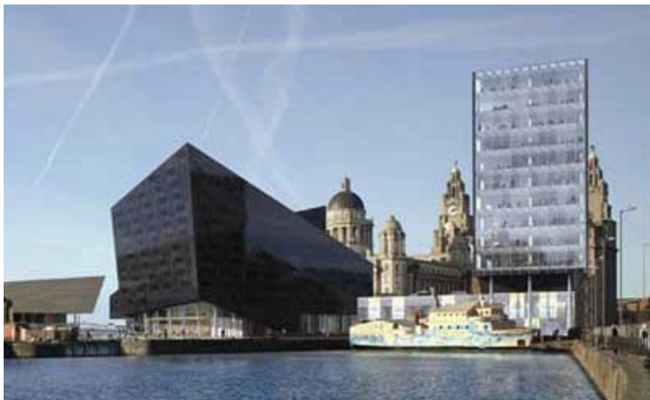
Die neu erworbene Büroimmobilie des hausInvest europa in Liverpool.
