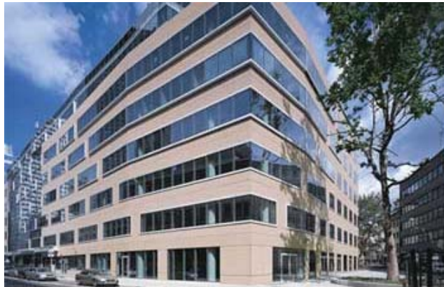
Die Büroimmobilie „Junghof Plaza“ in Frankfurt am Main.
