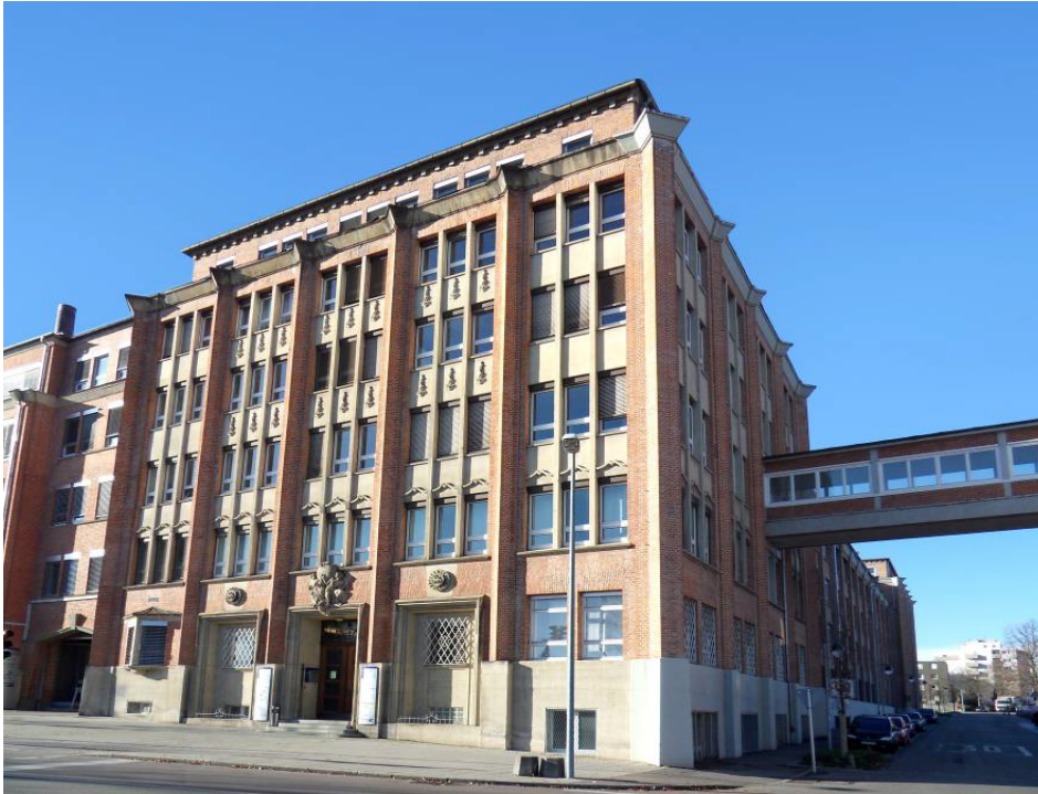
Ansicht Nord-Ost auf Bau 1
