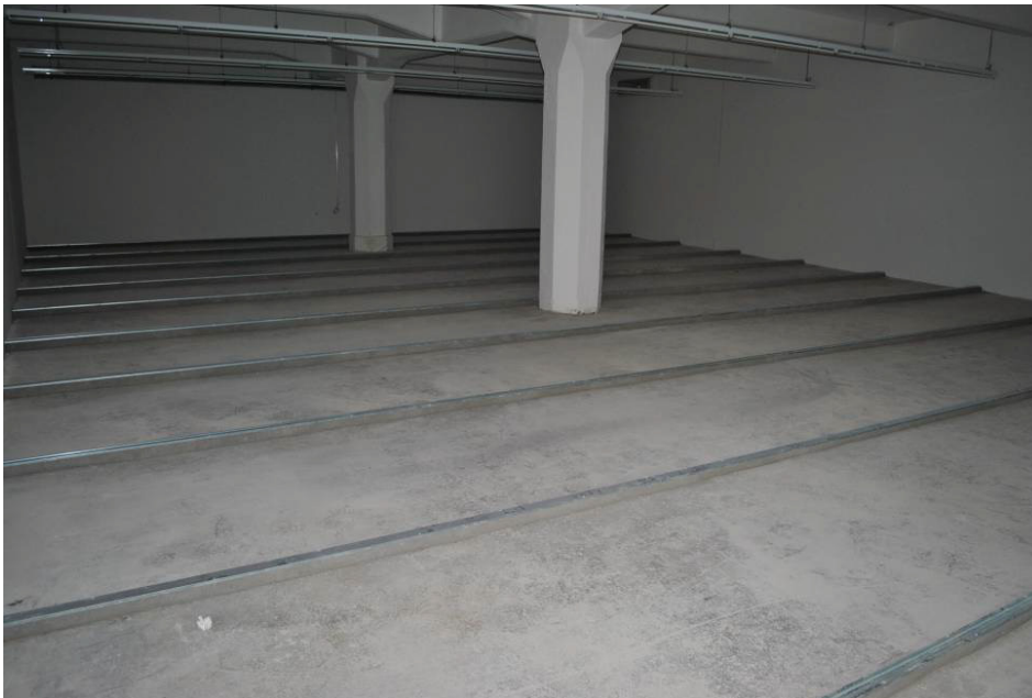
Vorbereiteter Ausbau für das Grundbuchzentralarchiv
