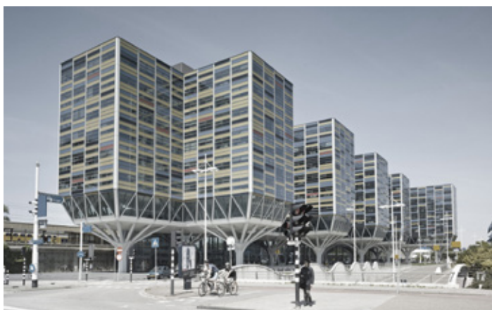
Dellaertweg, Leiden, Niederlande, Bürogebäude
