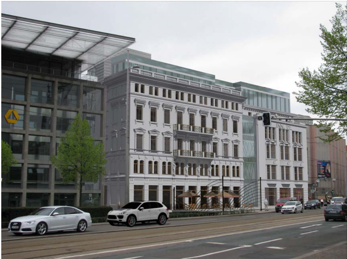
Hotel- und Restaurantensemble Kosmos: Ansicht Dittrichring
